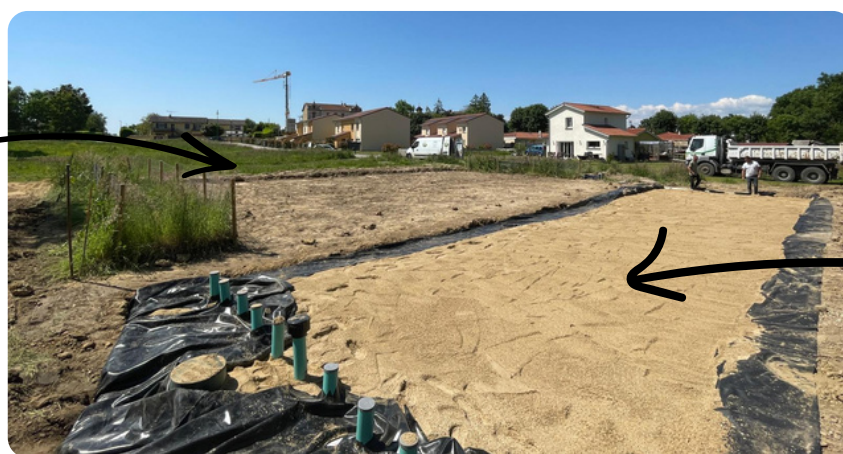
Vue globale des 2 filtres EnviroSeptic 100 EH + 40 EH
