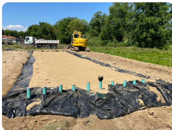
Extension du filtre EnviroSeptic 40 EH installé en 2025
