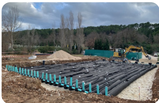
Mise en place du filtre EnviroSeptic 100 EH
