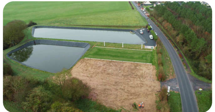
Vue aérienne de la réhabilitation complète de la station d'épuration
