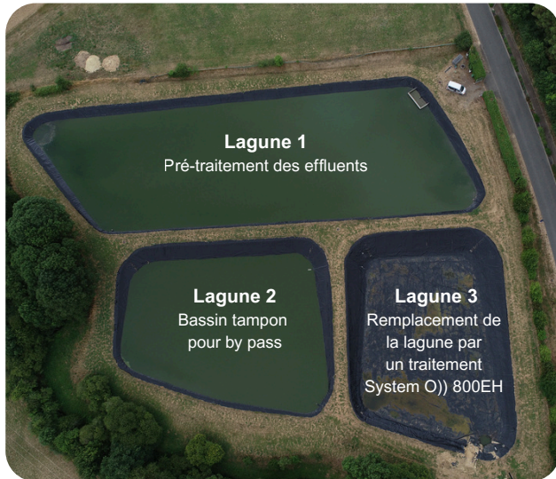
Photo aérienne des lagunes avant les travaux de réhabilitation
