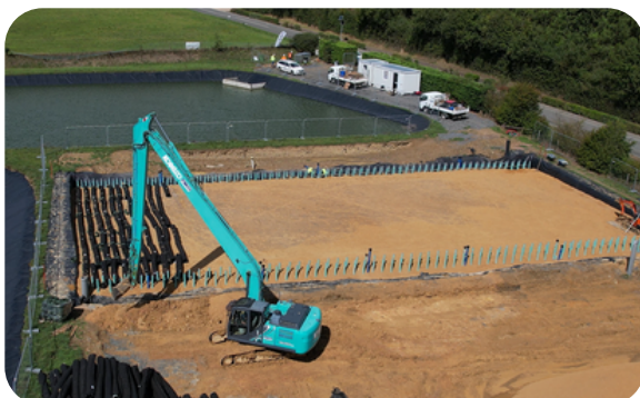
Pose du 2ème étage des conduites Advanced EnviroSeptic
