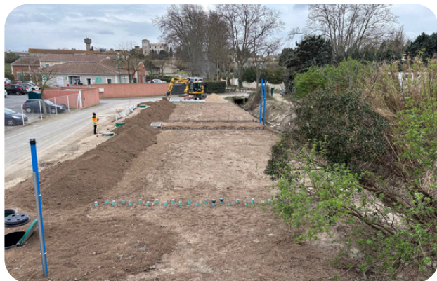
Filtres EnviroSeptic 300 EH recouvert de terre végétale
