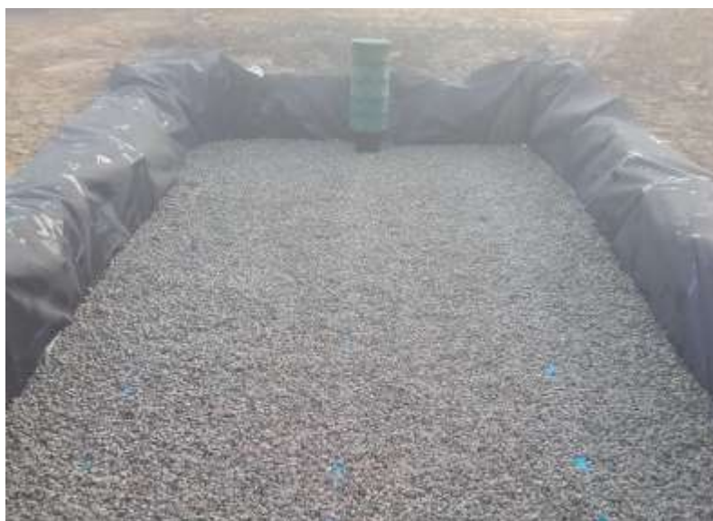
Figure 28 – Mise en place du gravier lavé 10/40 mm
