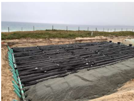
Mise en oeuvre du filtre - Recouvrement de l'EnviroSeptic
