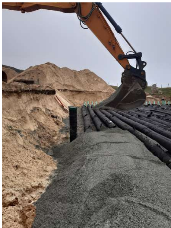
Recouvrement en sable des conduites EnviroSeptic et du bac échantillonneur
